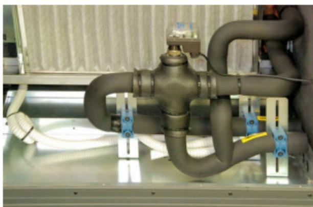
3-ходовой клапан с 3-позиционным приводом
